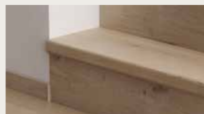
NOSEK SCHODOWY, ZLICOWANY Do tworzenia zlicowanych powierzchni na stopniach schodowych.
